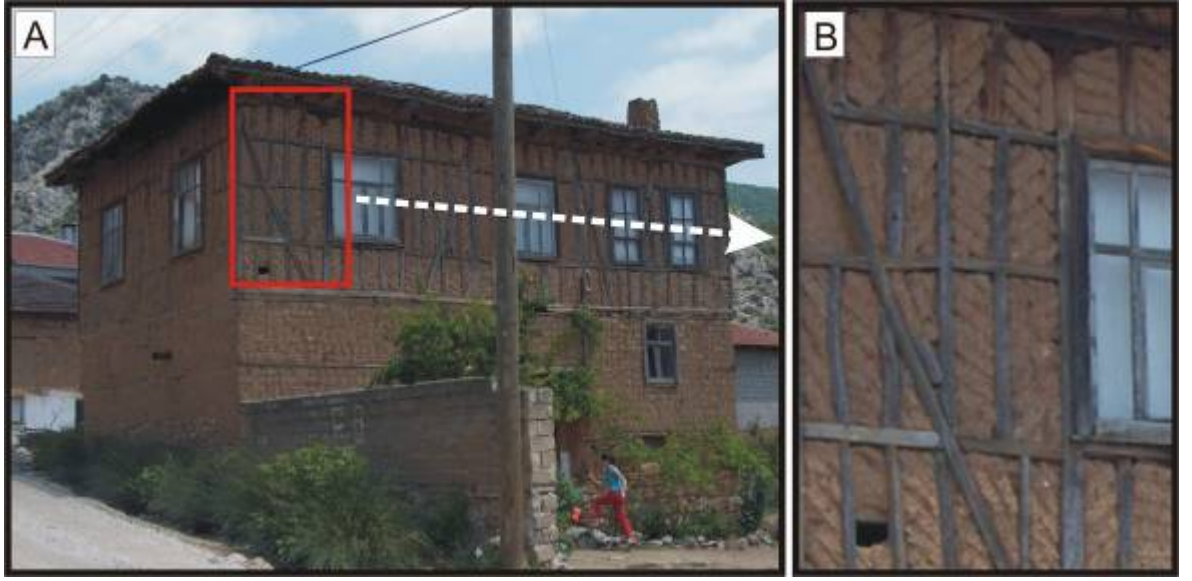
Foto 4 A: Ahşap ve kerpiçten faydalanılarak inşa edilmiş olan bir meskenin genel görünümü (Dereköy) B: Aynı meskenin yakın plan görüntüsünden de anlaşılacağı üzere, ahşap iskelet oluşturulduktan sonra arada kalan boşluklar kerpiçlerle doldurularak mesken tamamlanmıştır.
