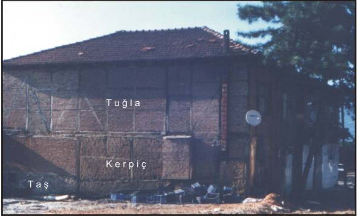
Foto 2: Ahşap, taş, kerpiç ve tuğlanın bir arada kullanılmasıyla inşa edilmiş bir mesken örneği (Karsak köyü). Meskenin duvarları yaklaşık 40 cm. yüksekliğe kadar taşla örüldükten sonra, ahşap iskelet kurulmuş, aradaki boşluklar ise kerpiç ve tuğladan faydalanılarak doldurulmuştur.
