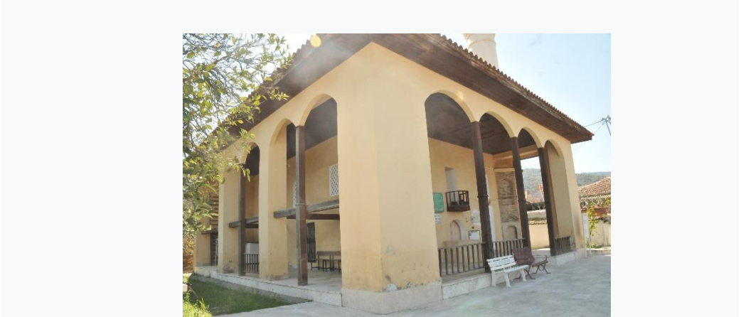
2. Posacızade Hacı Hasan ve Hacı Hüseyin Camii Son Cemaat Yeri. (O. Ülkü)
