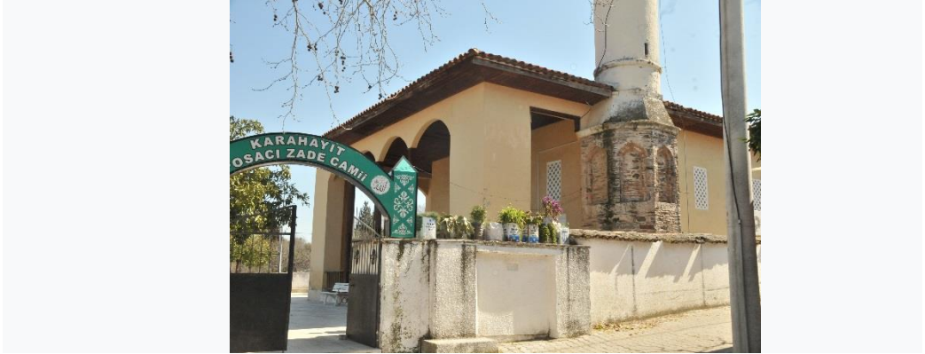
3. Posacızade Hacı Hasan ve Hacı Hüseyin Camii Son Cemaat Yeri (O. Ülkü)
