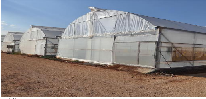
Şekil 1. Deneme alanı araştırma seraları Figure 1. Research greenhouses in the trial area
