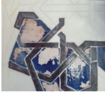
Şekil 13: Sırlı tuğla tekniğinde, harçla, birim formlar belirtilerek, hem yüzey tamamlama (solda). Şekil 14: Mozaik çini tekniğinde, harçla, birim formlar belirtilerek, hem yüzey tamamlama (sağda).
