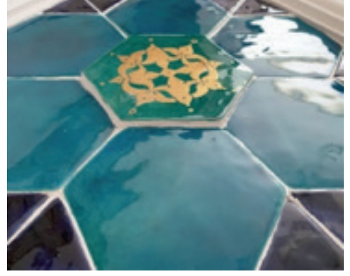
Şekil 27: Tek renk sırlı çini tekniği ve tek renk sırlı yaldızlı çini tekniğinde, yeniden üretim çinilerle tamamlama (solda). Şekil 28: Tek renk sırlı çini tekniği ve tek renk sırlı yaldızlı çini tekniğinde, yeniden üretim çinilerle tamamlama, detay (sağda).
