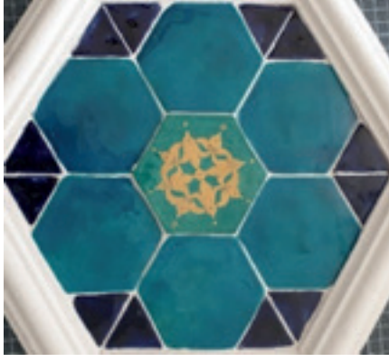
Şekil 27: Tek renk sırlı çini tekniği ve tek renk sırlı yaldızlı çini tekniğinde, yeniden üretim çinilerle tamamlama (solda). Şekil 28: Tek renk sırlı çini tekniği ve tek renk sırlı yaldızlı çini tekniğinde, yeniden üretim çinilerle tamamlama, detay (sağda).
