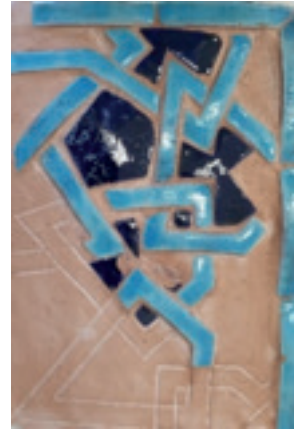
Şekil 22: Mozaik çini tekniğinde, puzolan harçla, hem yüzey tamamlama (ortada).
