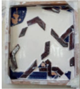
Şekil 4: Yapısal eksikliklerin harçla tamamlanması (solda).
