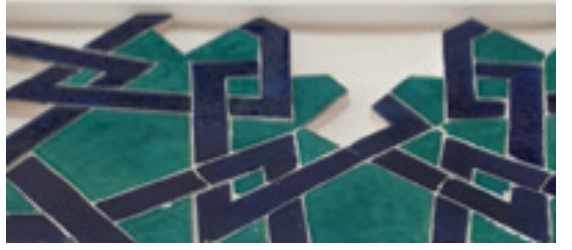
Şekil 15: Mozaik çini tekniğinde, harçla, seviye altı tamamlama (solda).
