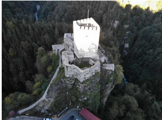
Res. 8. Zir Kale Güneybatı Cephe
