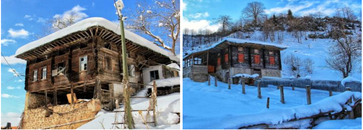
Res. 3, 4. Taş Duvar Kurgusu, Ahşap Çatki Sistem Bağlantılı Geleneksel Evler (N. Yazıcı Arşivi)
