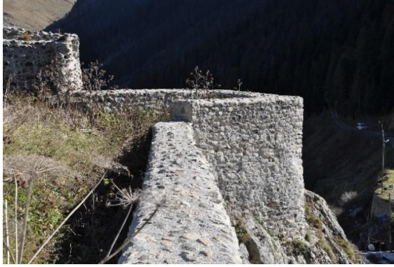
Res. 53. Batı Sur Duvarı ve Burçları
