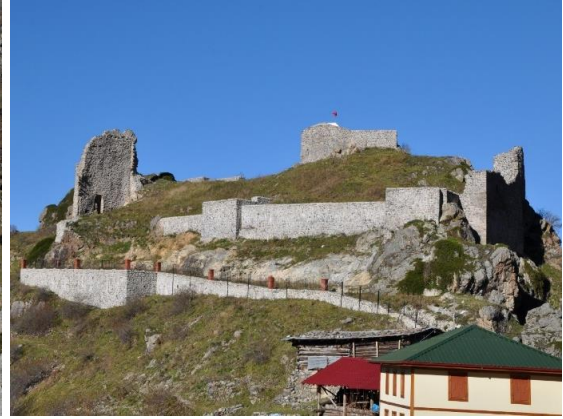
Res. 50. Batı Sur Duvarı
