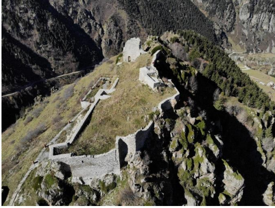
Res. 45. Kale-i Bala Güney Cephe
