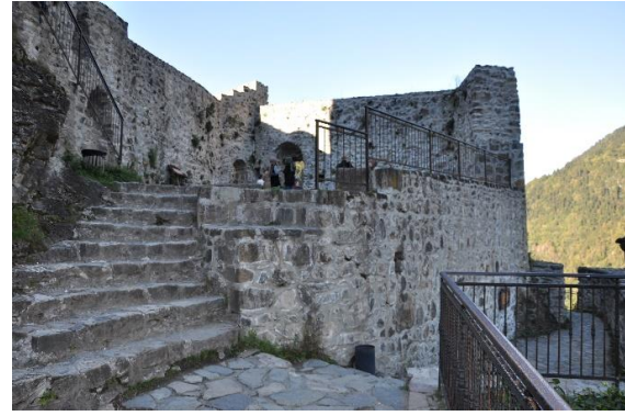
Res. 14. Koridor ve Avluya Geçiş
