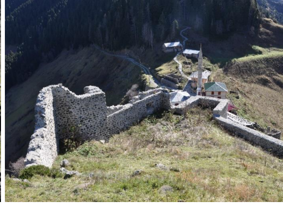
Res. 46. Kale-i Bala Güney Sur Duvarı
