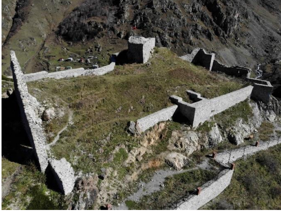
Res. 51. Kuzeybatı Cephe
