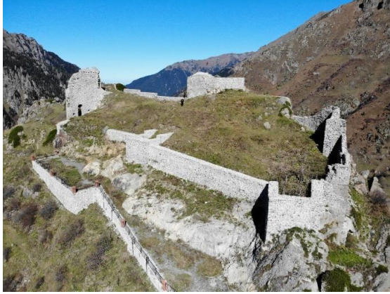
Res. 49. Güneybatı Cephe
