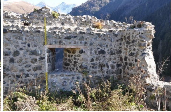
Res. 48. Güney Sur Duvarındaki Pencere
