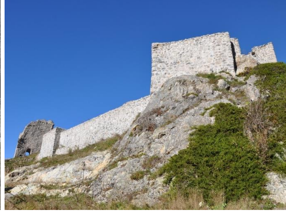
Res. 52. Batı Sur Duvarı ve Burçları
