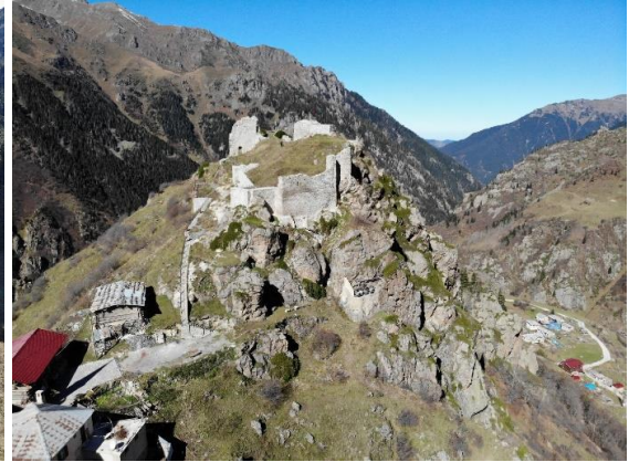
Res. 40. Kale-i Bala Güney Cephe
