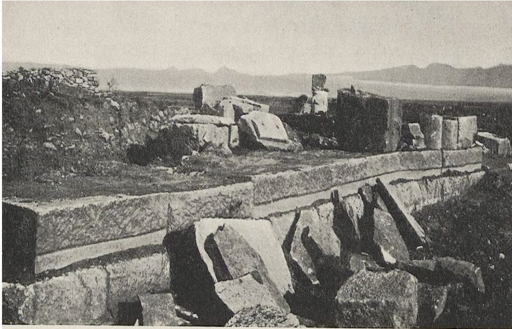
Abb. 16. Obere Terrasse. Nordende der Westhalle. Stylobat
