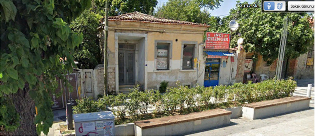
Şekil 18. Aynı Parseldeki Konutun Müdahale Öncesi Google Street Görüntüsü (2016)
