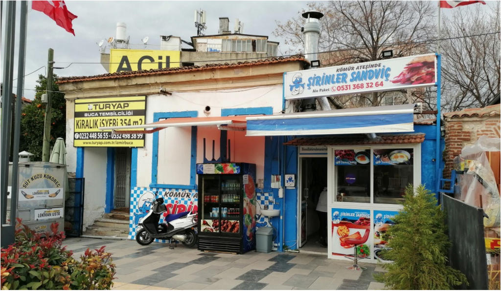
Şekil 19. Şekil 18'deki Konutun Müdahale Sonrası Görünümü
