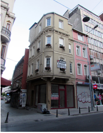
Şekil: 3 Çalışma alanında yer alan yapı adalarından görünüşler (Okuyay, 2015).
