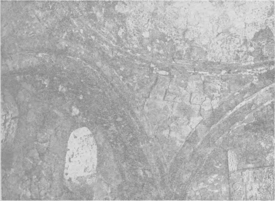
Res. 4- Mihrab önündeki kubbenin pantantiflerinden biri Pl. 4- L'un des pendants de la coupole devant le mihrab.
