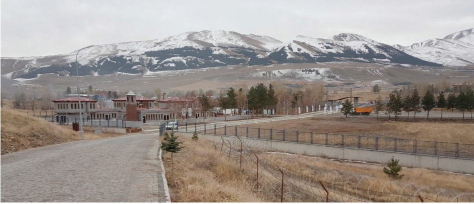
Şekil 9. İlk Etapın Uygulaması
