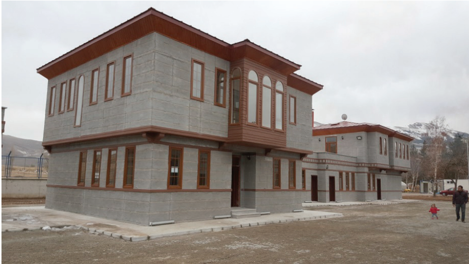
Şekil 16. Erzurum Konağının Giriş ve Yan Cephesi
