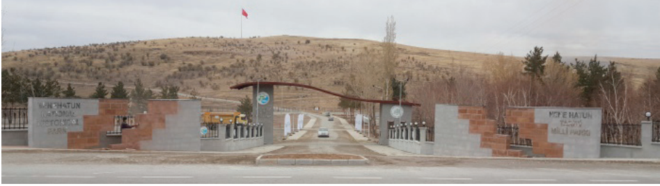
Şekil 11. Giriş Kontrol Ünitesinin Sahada Uygulanmış Hali
