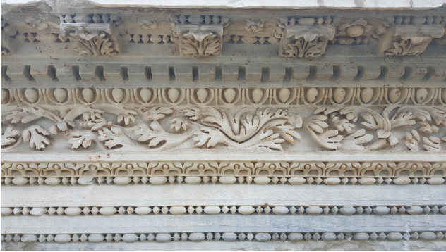
Figür 7. Geison, Friz ve Arşitrav / Geison, Frieze and Architrave of the Pediment (N. Yıldırım).
