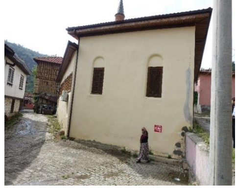
Fotoğraf 4: Kemaliye Köyü Camii Güney Cephesi
