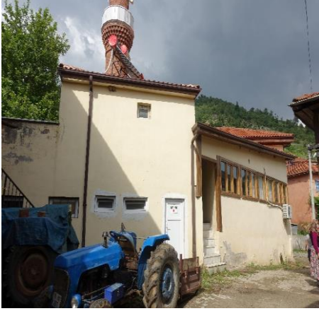
Fotoğraf 5: Kemalîye Köyü Camii Batı Cephesi
