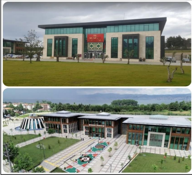
Şekil 8. Üste Başiskele Kaymakamlığı binası, altta Başiskele Belediye binası.
