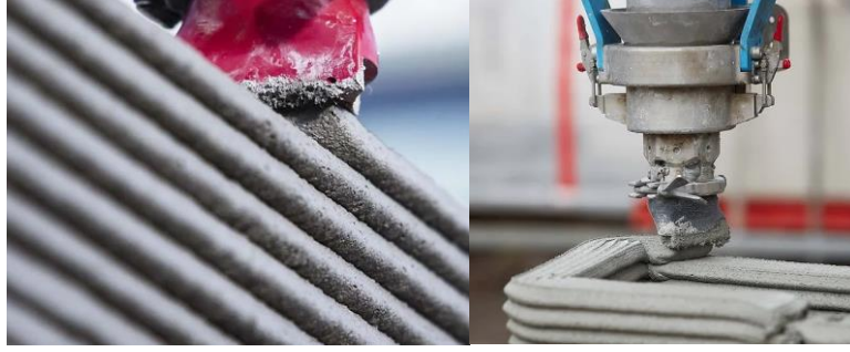
Şekil 1: 3d inşaat baskısı (PERI, 2024).
