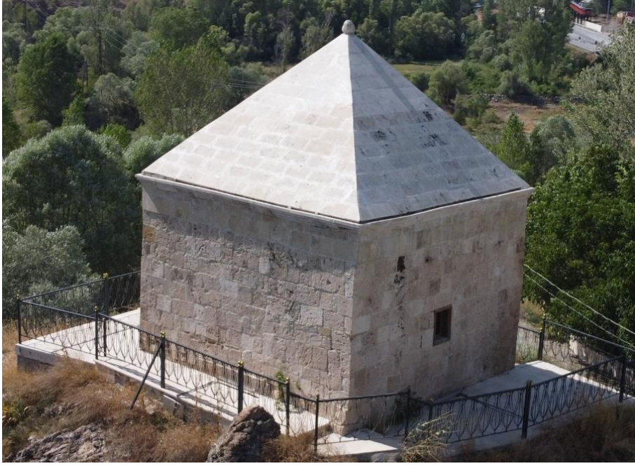
Resim 23. Güney ve doğu cephe görünümü
