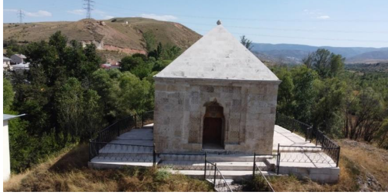
Resim 21. Kuzey cephe görünümü
