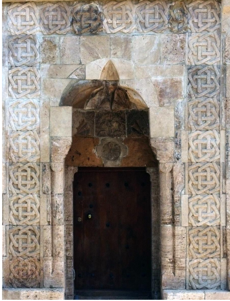
Resim 24. Kuzey cephe taçkapı
