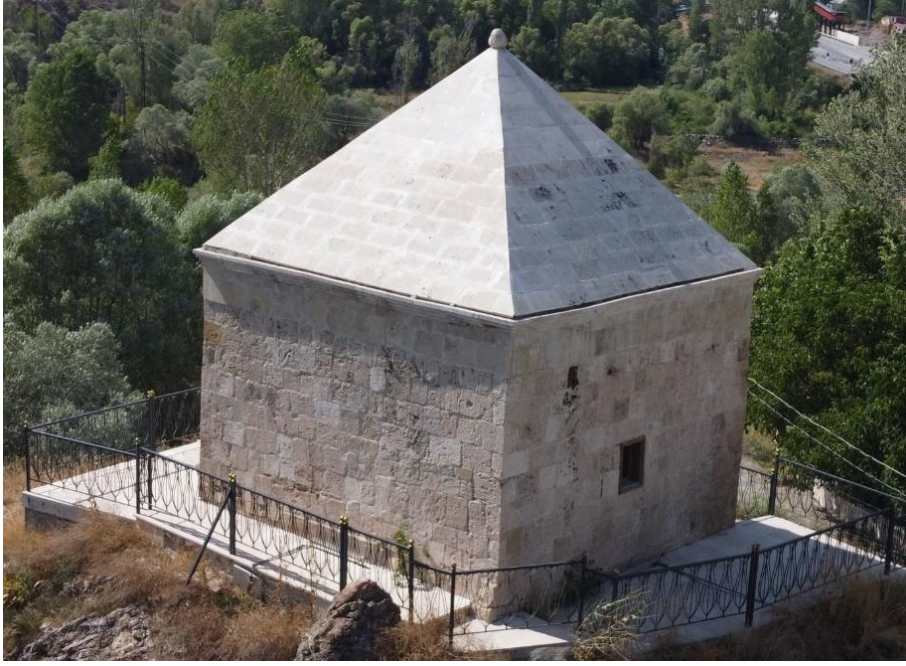
Resim 23. Güney ve doğu cephe görünümü
