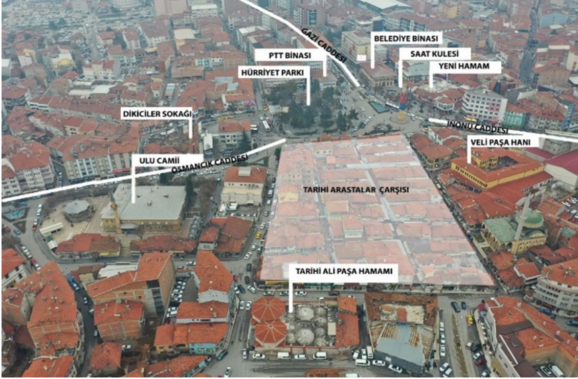
Şekil 5. Çalışma Alanında Tarihi Referans Yapıların Yoğunlaştığı Saat Kulesi ve Çevresi
