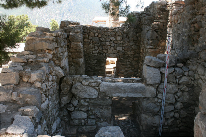
Fig. 8 Küçük Hamam, Tepidarium, Batı Duvar
