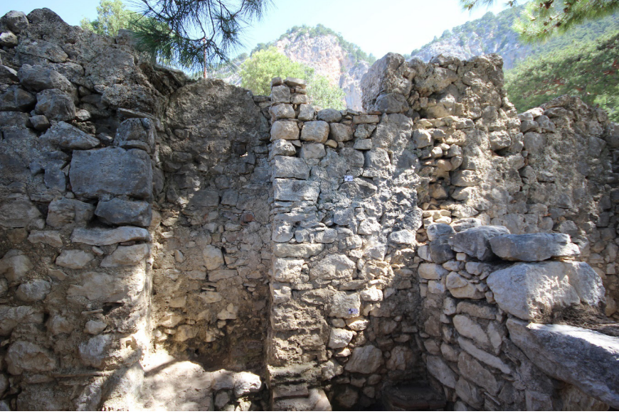
Fig. 11 Küçük Hamam, Caldarium, Kuzey Duvar
