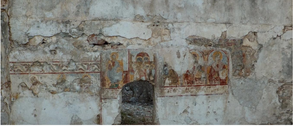
Figür 7. Naos güney duvarı
