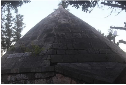
Fotoğraf 7: Sinan Paşa Kümbeti Üst Örtü Külâh Görünüşü
