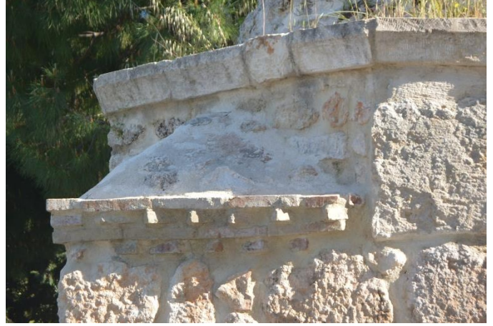
Fotoğraf 14: Anonim Türbe Köşe Üçgen Geçiş Detay
