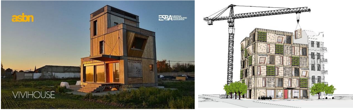
Görsel 20. Vivihouse, 2019, açık kaynak kullanımına izin veren prefabrik ahşap saman panel sistemi ve şehir içi çok katlı uygulama anlatımı.
