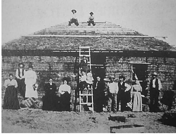
Görsel 4. 1908 Yapım tarihli Simonton Evi.
