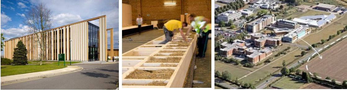
Görsel 19. 2012 tarihli, saman panel giydirme cephe uygulaması, Nottingham Üniversitesi.
