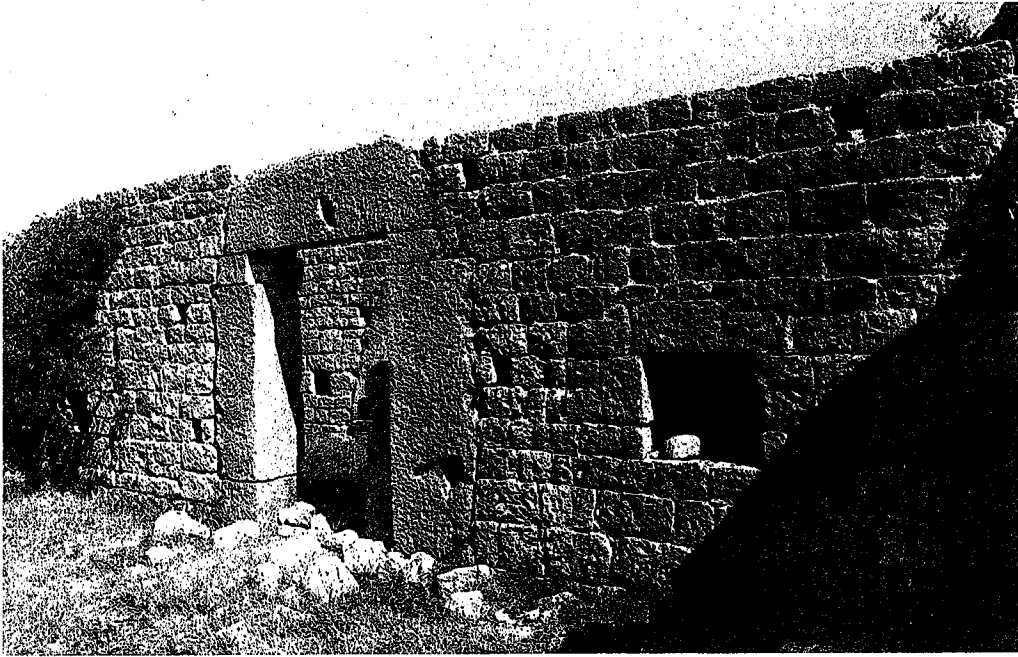
Resim 6 : 4 No.lu ev, avlu ile evi ayıran duvar
