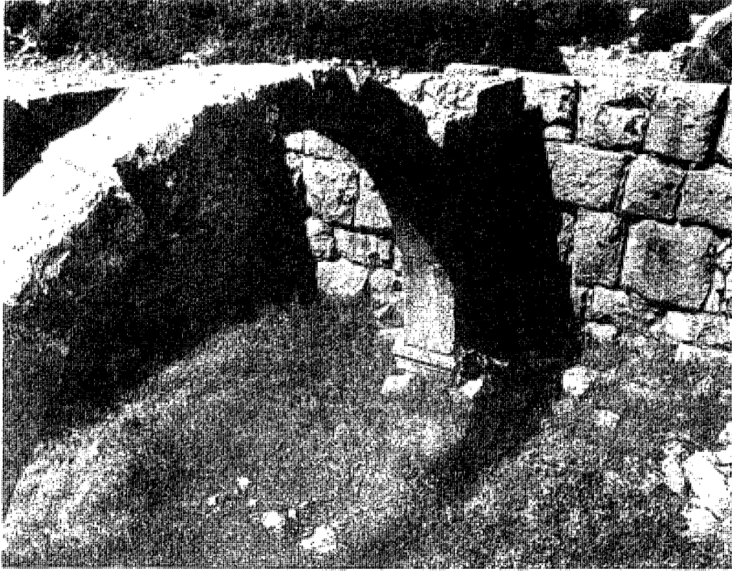
Resim 7: 4 No.lu ev, birinci mekandaki taşıyıcı kemer
