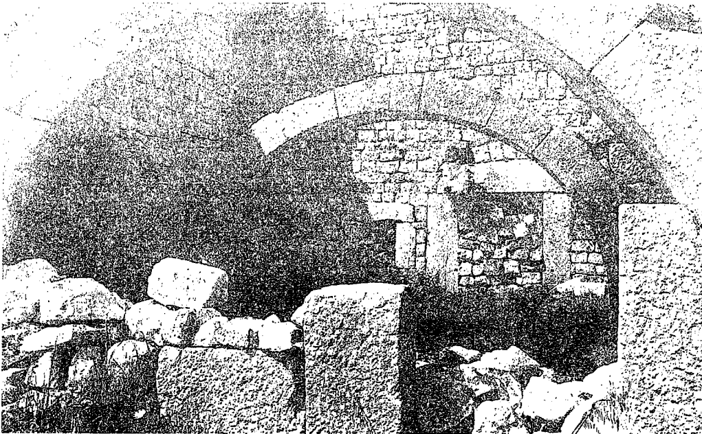
Resim 10 : 5 No.lu ev, taşıyıcı kemer
