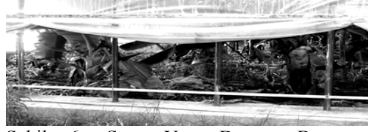
Şekil 6. Sera Yan Duvarı Boyunca Merteklerin 75 cm Ara İle Yerleştirildiği Örnek Bir Sera
