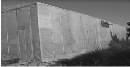
Şekil 3. Örtü Malzemesinin Konstrüksiyon Üzerine Yerleştirilmesinde Demir Izgaraların Kullanıldığı Örnek Bir Sera
