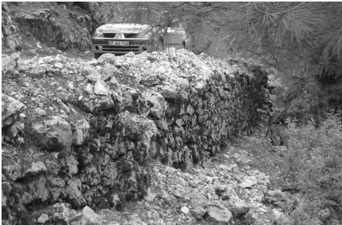
Abb. 8: Antike Straße mit Stützmauer zwischen Neisa und Kandyba
