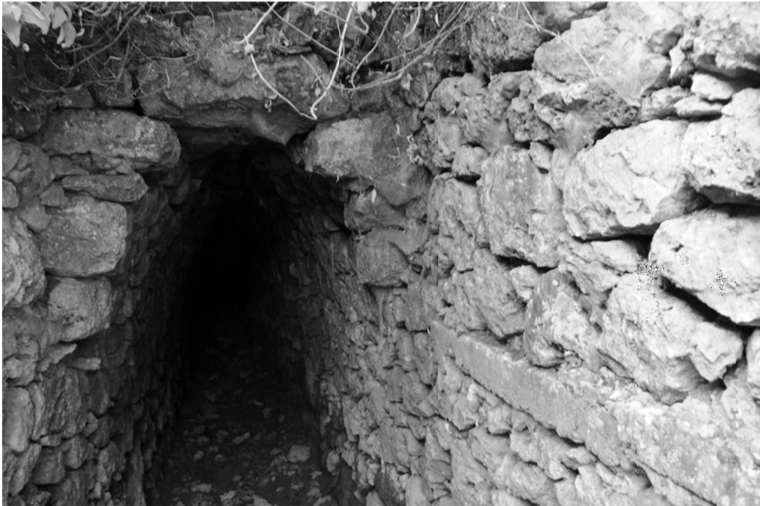
8. Der Ausgang des Entwässerungstunnels
