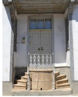
Şekil 22. Merdiven İki Yandan (2 No'lu Konut)
