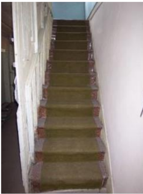
Şekil 8. I Formda Merdiven (47 No'lu Konut)*
