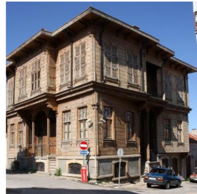
Şekil 33. Bodrum kat hizasında taş; katlar arası pro- filli ve ahşap köşe dikmeleri (12 No'lu Konut)
