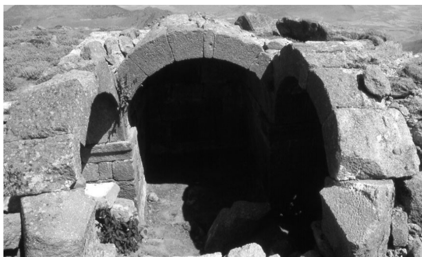
Abb. 7) Kapelle 2, Vierung mit Blick nach Norden
