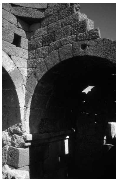
Abb. 4) Kirche 1, Vierung, Gewölbeansatz
