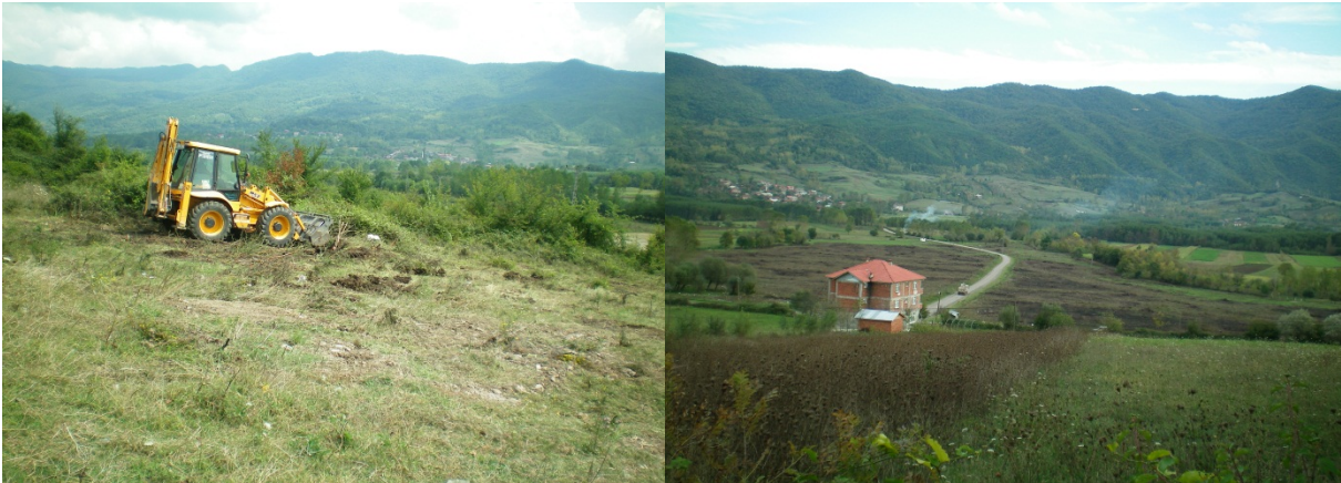
Şekil 2: Mera ıslah çalışması öncesinde bitki örtüsünün mekanik mücadele yöntemi ile kaldırılması.
