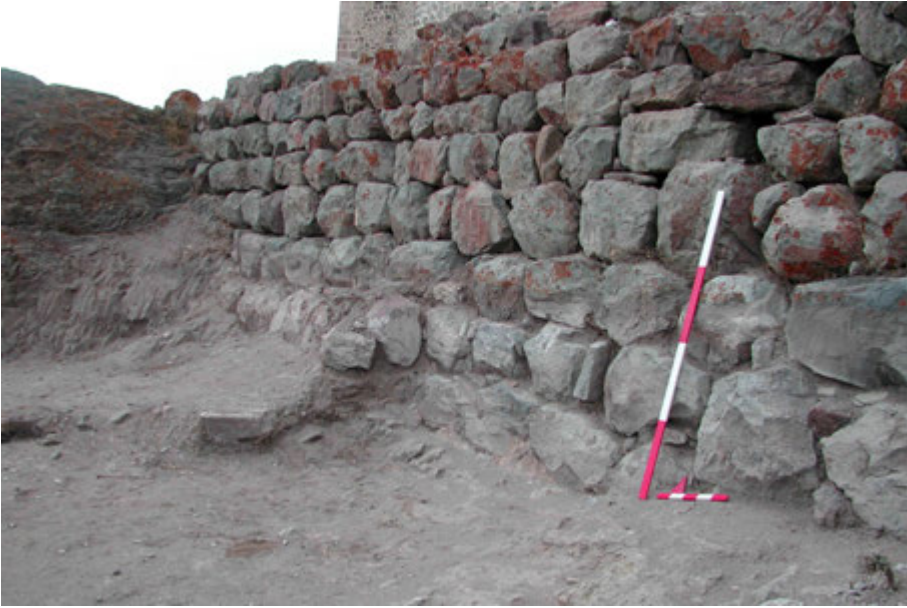
Foto. 8: Pasinler Kalesindeki Kiklopik Duvarda Geriye Doğru Eğim Verme Metodu.
