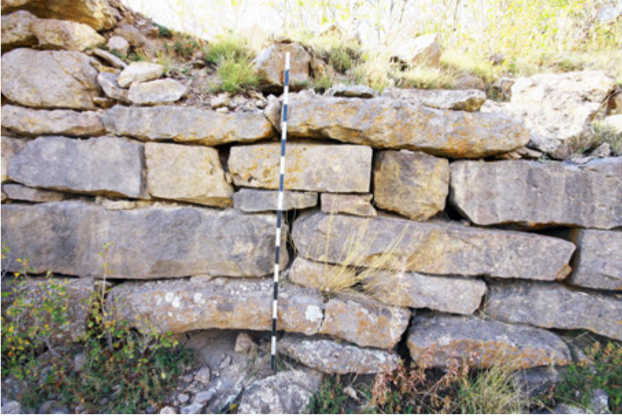
Foto. 5: Hanahmet Kalesinde Farklı Büyüklükteki Taşların Bir Arada Kullanıldığı Sur Duvarı.
