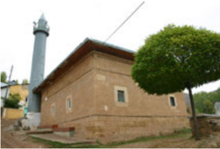
Foto. 3: Caminin güneybatı cephesi.
