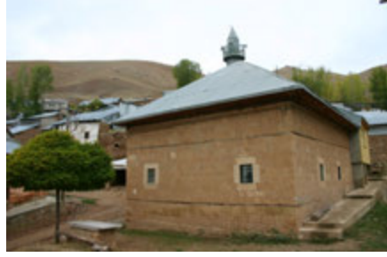
Foto. 2: Caminin güneydođu cephesi.
