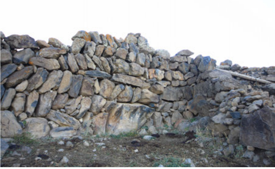
Foto. 7: Karakale Kalesindeki Balıksırtı Denilen Örgü Türündeki Sur Duvarı.
