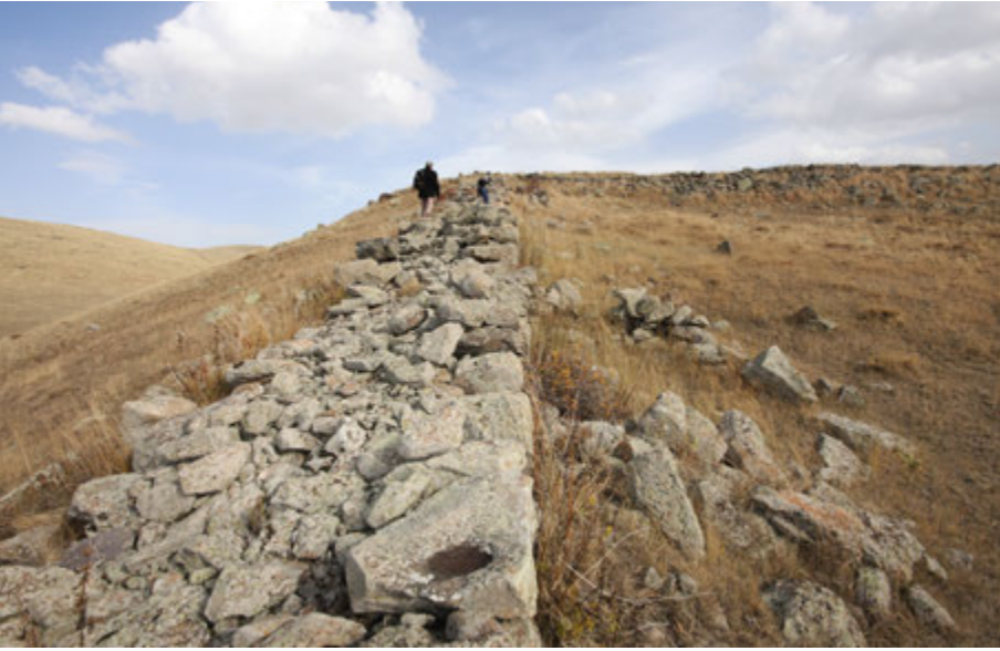
Foto. 10: Yukarı Iğırbiğir Kalesindeki Sur Duvarının Genişliği ve İç Dolgu Malzemesi.
