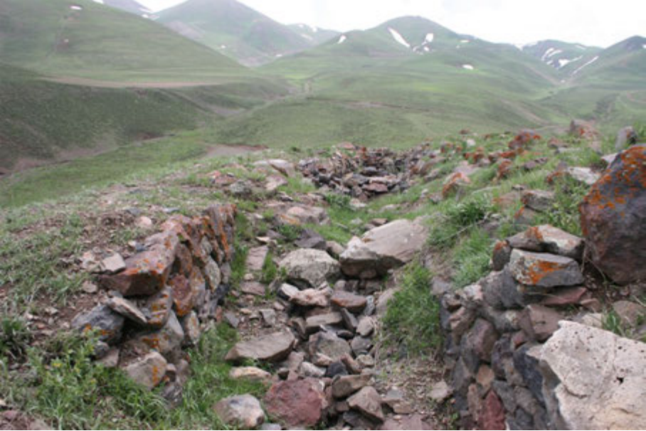
Foto. 14: Pirali Baba Kalesindeki Çift Sur Uygulaması.
