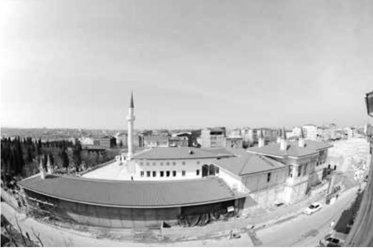
27- Okmeydanı Okçular Tekkesi yeniden inşa sonrası.
