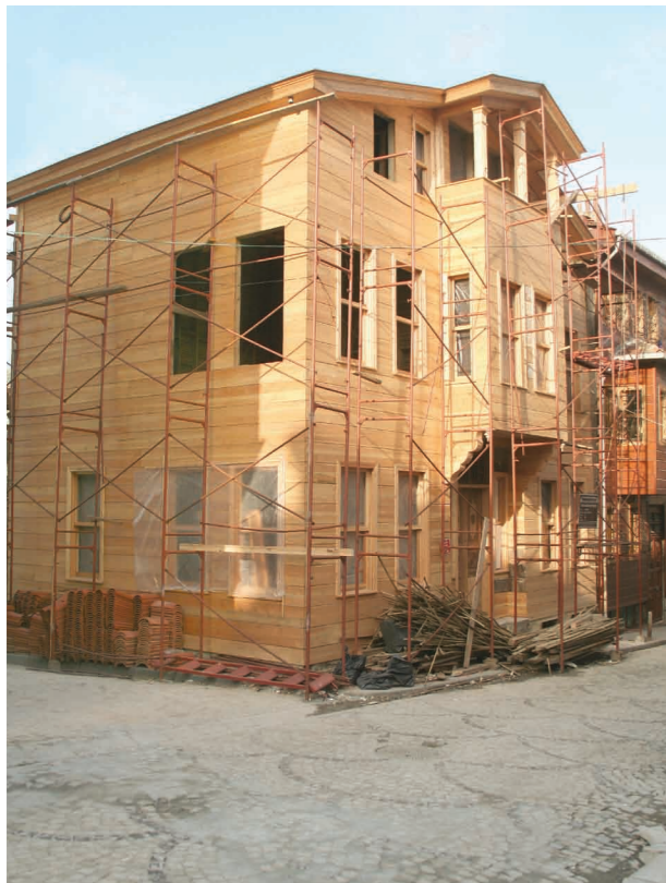
Süleymaniye, Kayserili Ahmetpaşa Sokağı, 569ada 13 parselde yer alan ahşap yapının eski hali ve uygulama sonrası fotoğrafları
