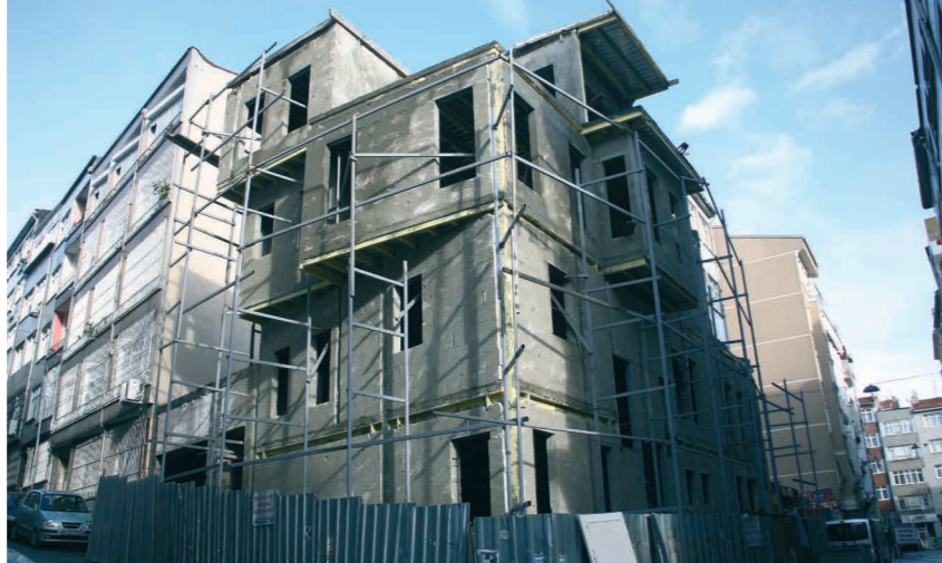
Fatih- Karakadı sokak 2002 ada 25 parselde yer alan özgün hali ahşap olan yapıda çelik-betonarme malzemeyle rekonstrüksiyon uygulaması
