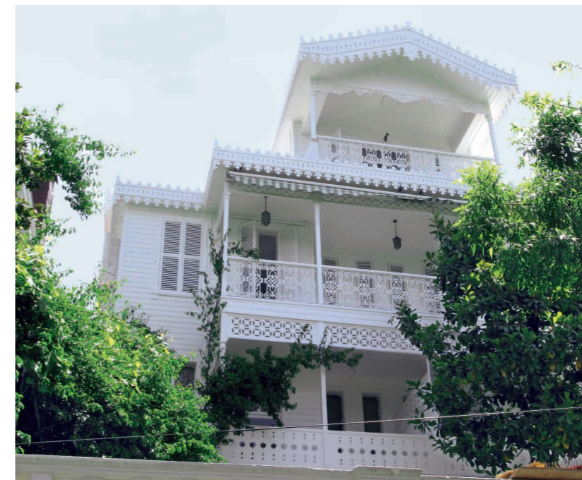
Bakım-onarım izni verilen yapının onarım sonrası görünümü.
