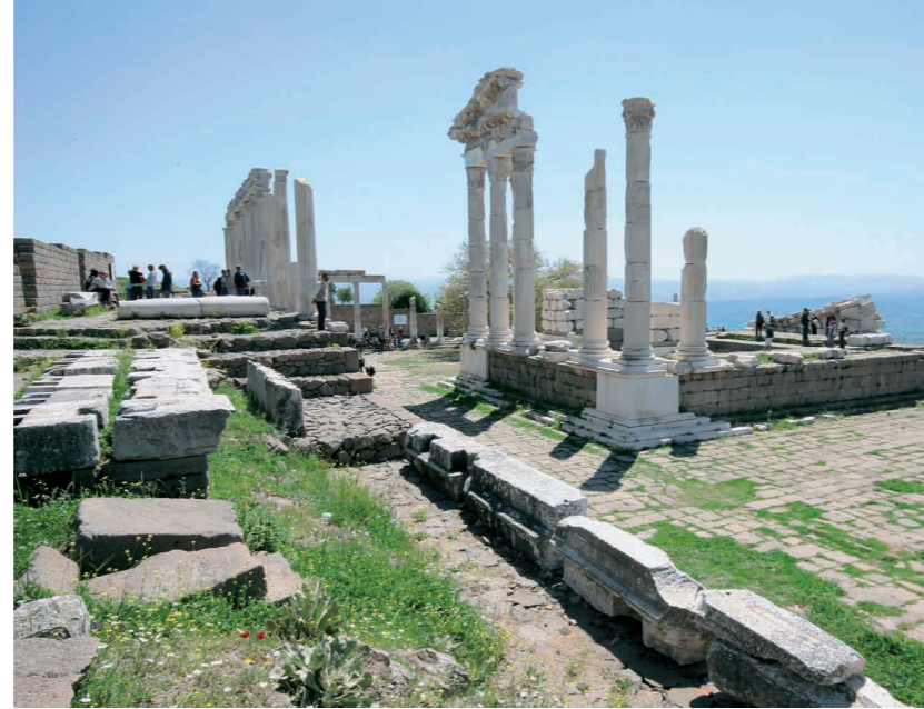
(Üstte) Özgün parçalarının minimum yeni malzemeyle biraraya getirildiği anastylosis uygulaması (Bergama)
