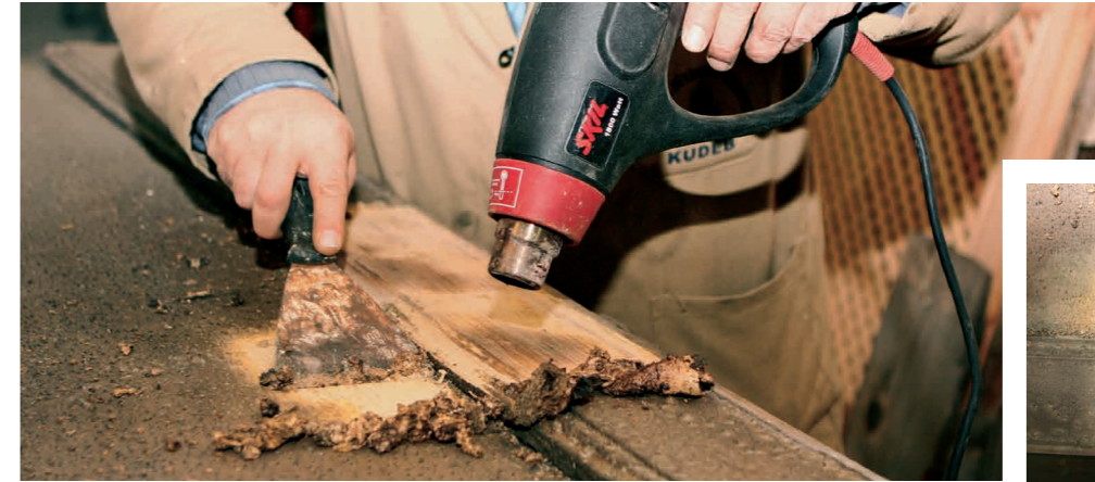
Mekanik yöntem ve ısı yöntemi ile boya sökümü
