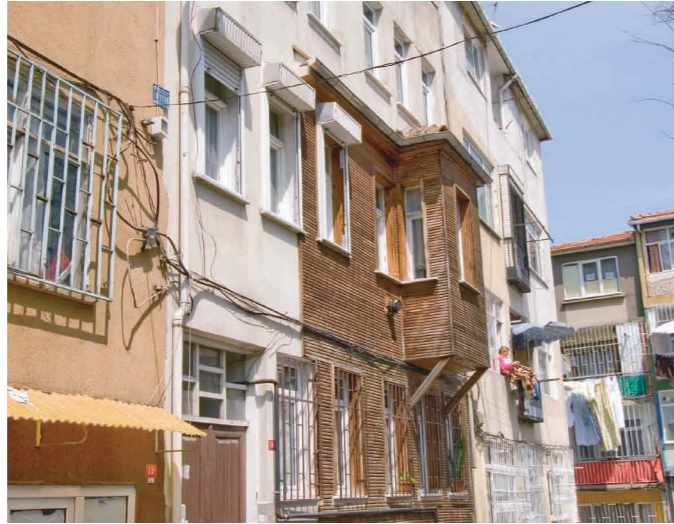
Fatih- Karakadı sokak 2002 ada 25 parselde yer alan özgün hali ahşap olan yapıda çelik-betonarme malzemeyle rekonstrüksiyon uygulaması
