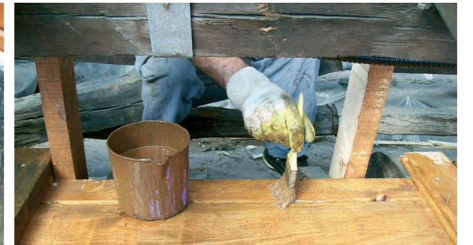
Fırçayla sürme yöntemiyle empenye (Yeni Cami Hünkâr Kasrı çalışmaları)
