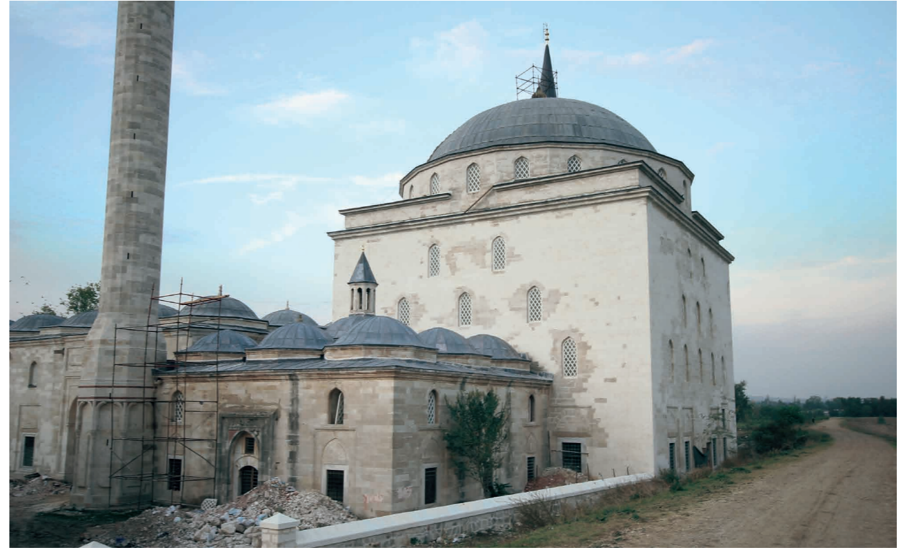
Edirne II. Beyazid Külliyesi'nde aşırı plastik onarım uygulaması sonucunda yapının patina ve yaş değerinin kaybolması
