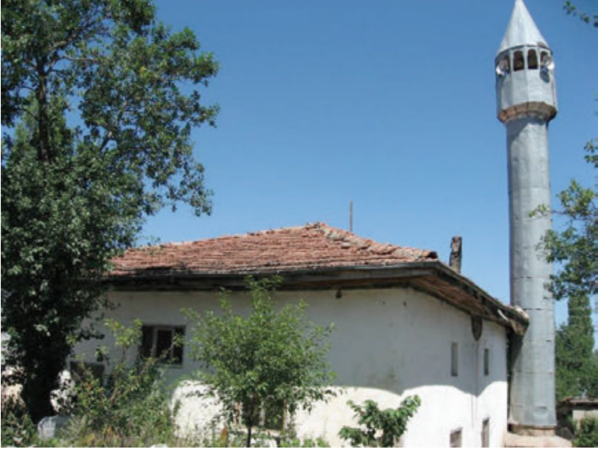
Foto. 41: Kızılcaören Köyü Camii Restorasyon Öncesi (V.G.M.'den)
