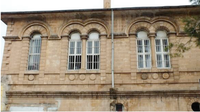
Foto. 6: Basmahane, Batı Cephesi Birinci Kat Pencerelerinden Ayrıntı
