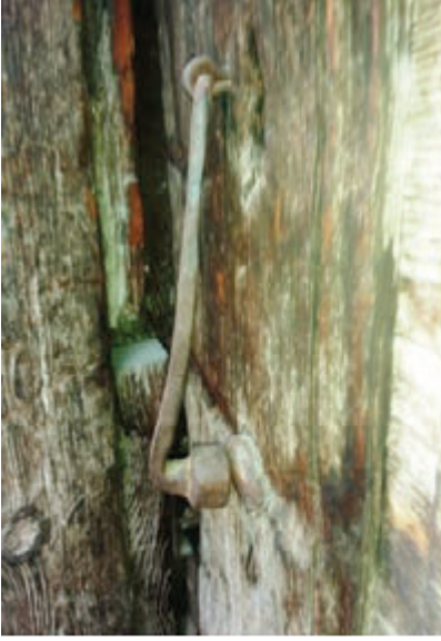
Foto. 17: Tabakhane Mahallesi Delibey Sokak No.8
