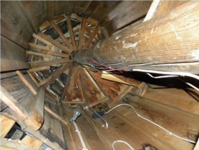
Foto. 20: Seyyid Necmeddin Camii Minare İç Kısım
