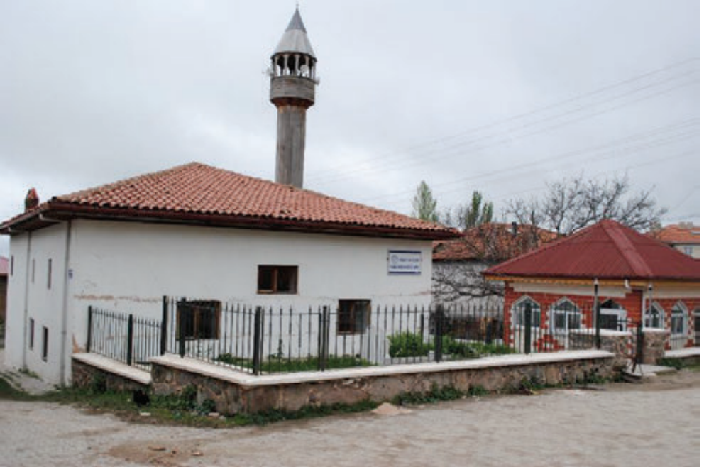
Foto. 38: Kızılcaören Köyü Camii Genel Görünüş
