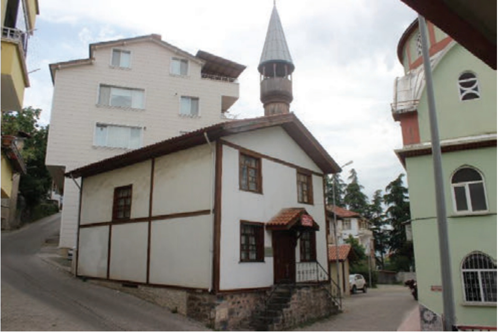
Foto. 31: Niksar Hanegah Camii Genel Görünüş
