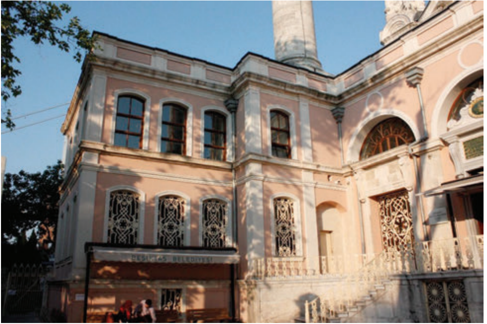
Foto. 10: Ortaköy Camii, Doğu Cephesi Mektep Binası
