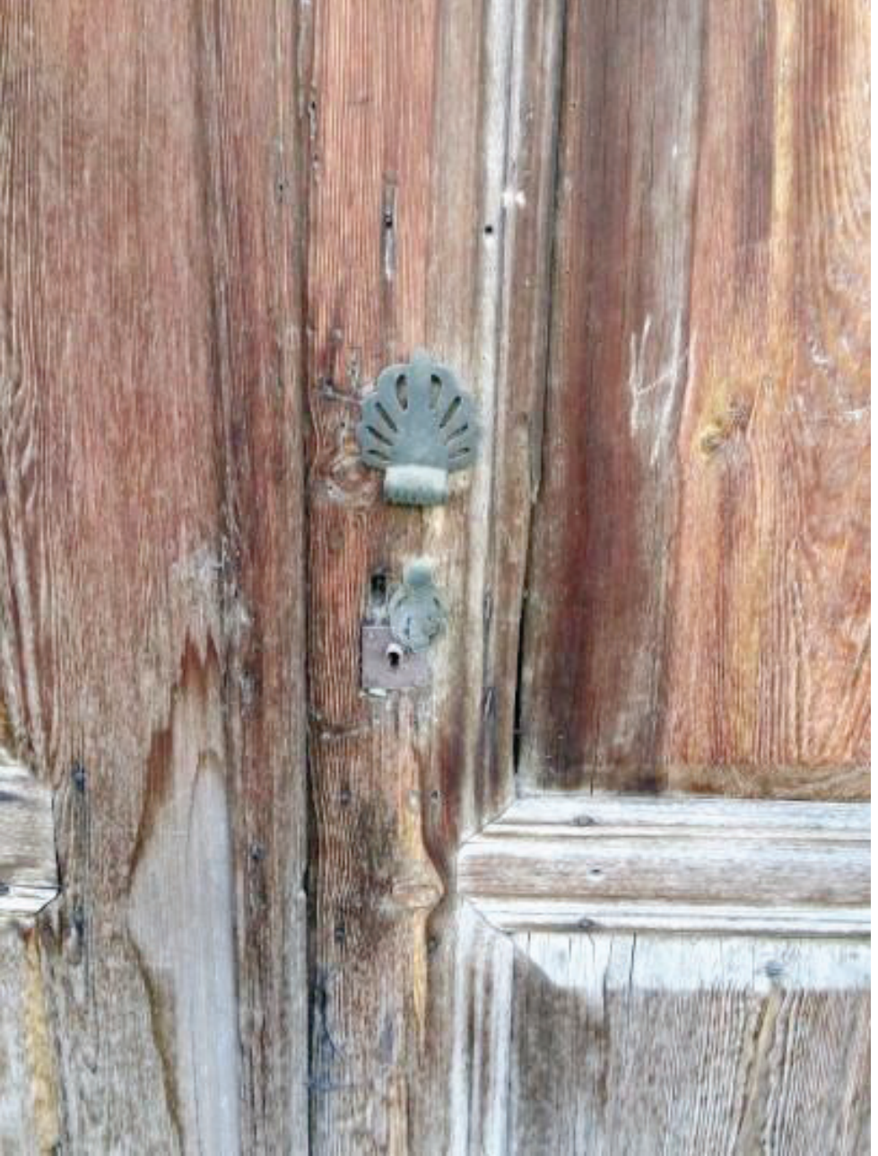
Foto. 16: Tabakhane Mahallesi Ağalar Sokak, No: 9/1
