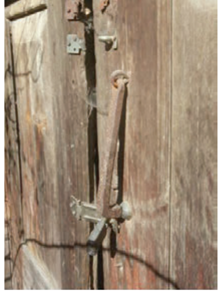
Foto. 18: Karasait Mahallesi Köşköntü Sokak No.30\1
