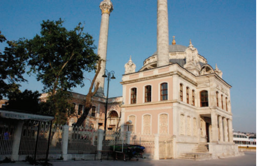
Foto. 8: Ortaköy Camii, Hünkâr Dairesi ve Hünkâr Girişi
