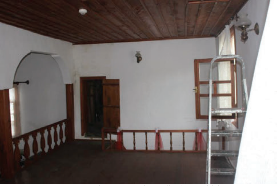
Foto. 33: Niksar Hanegah Camii Minare Girişi
