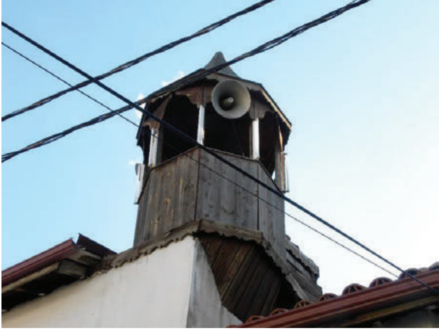
Foto. 15: Hoca Ahmet Camii Minare
