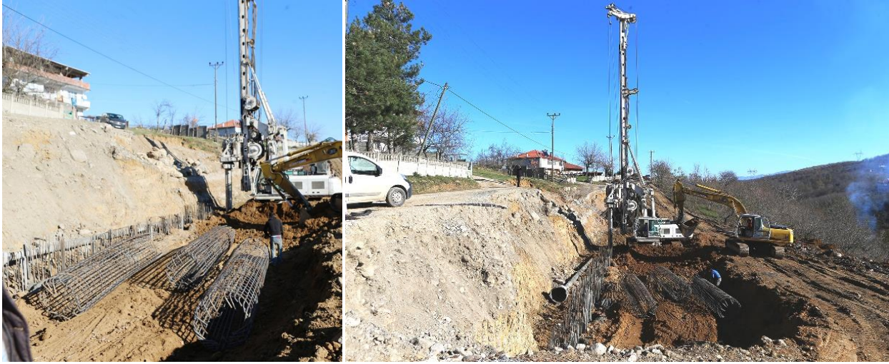
Şekil 16. Kazık delgi işlemi ve donatıların hazırlanması
