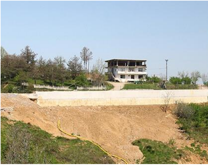
Şekil 14. İmalat sonu konsol duvarın karşı yamaçtan görünümü
