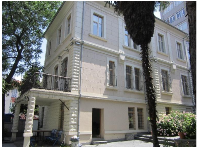
Foto.8: Şahinzade Remzi Bey Konağı kuzeybatı cephesi
