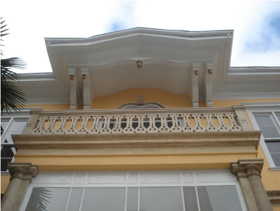
Foto.25: Eski TÖB-DER/Binası Takas Odası saçak ve balkon korkulukları
