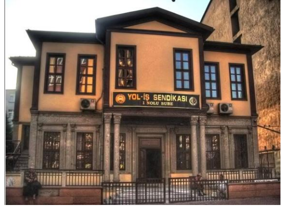
Foto. 6: Yol-İş Sendika Binası genel görünüm
