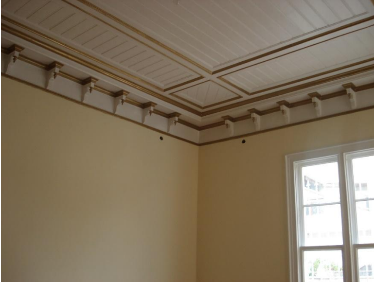
Foto.23: Eski TÖB-DER Binası/Takas Odası zemin kat tavan kaplaması
