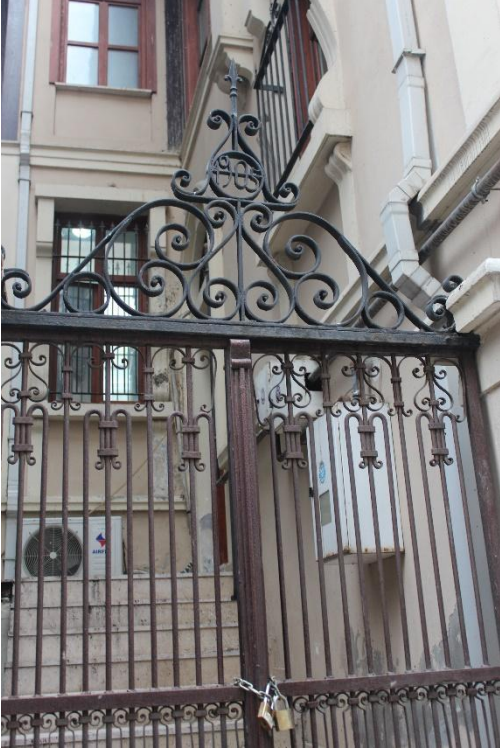
Foto. 1: İlkadım Gençlik Merkezi doğu cephesi ikinci kat giriş kapısından ayrıntı.
