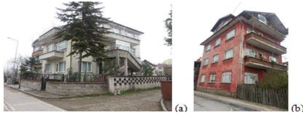
Şekil 3. Araştırma alanlarında bulunan orta durumdaki yapılardan örnekler: (a) Kemal Samancıoğlu Sokak, (b) Turna Sokak.
