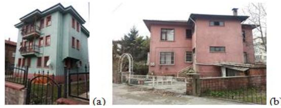
Şekil 4. Araştırma alanlarında bulunan betonarme yapılardan örnekler: (a) Kemal Samancıoğlu Sokak, (b) Turna Sokak.
