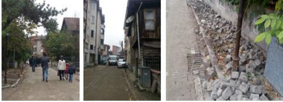
Şekil 8. Araştırma alanlarında bulunan kaldırımların mevcut durumu.
