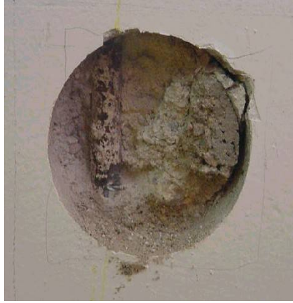
Şekil 12. Taşıyıcı bir elemanda donatının kesilmesi
