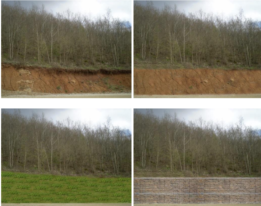
Şekil 17. Şev yüzeyinde toprak kayması ve peyzaj onarım önerileri
