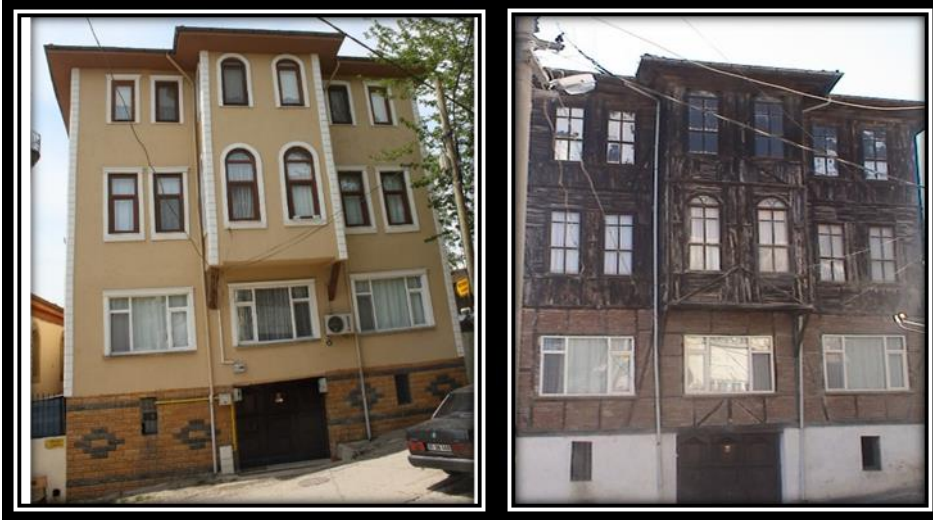
Resim 8. Tadilat Görmüş Tescilli Yapı (Anon, 2013)
