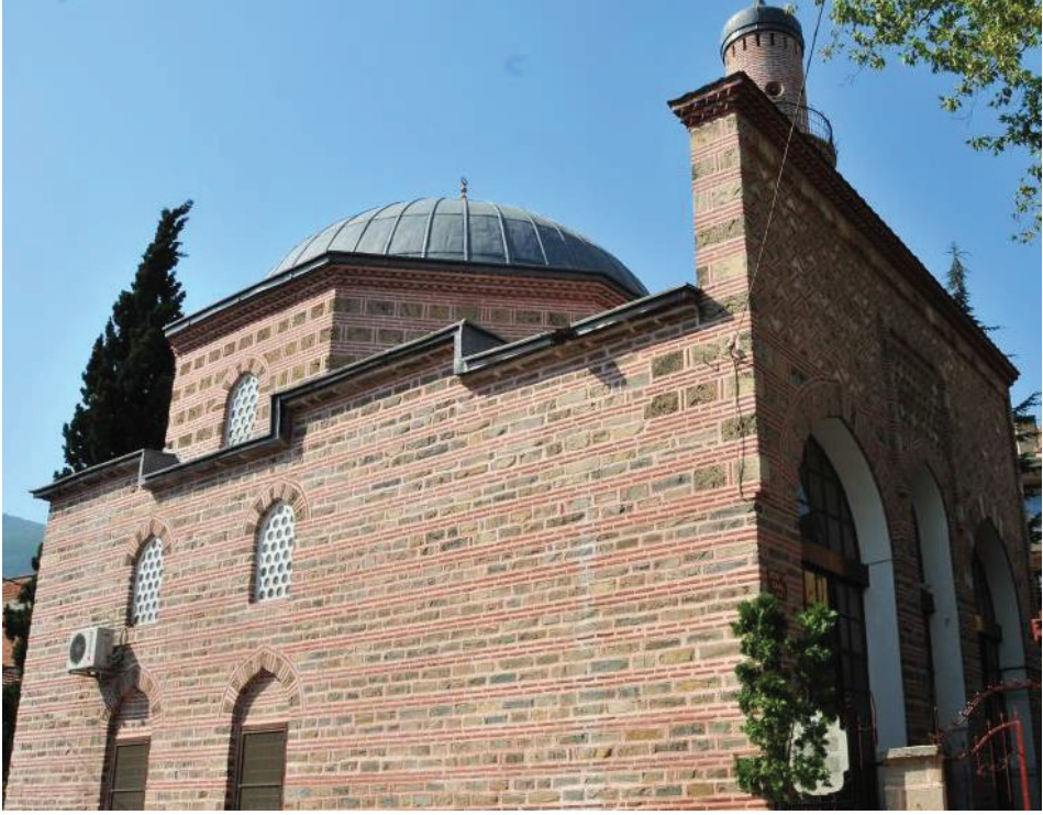
Fotoğraf 2: Bursa Bedrettin (Hafsa Sultan) Camii. (1443) ( www.kulturportali.gov.tr )
