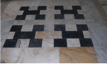
Fot. 25: Sağdaki galerinin 5. bölüm zemini.
