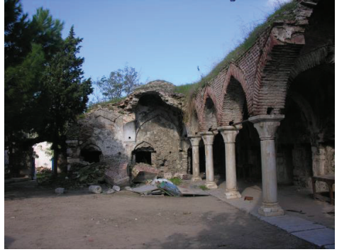
Fot. 7: Medresenin güneyden kuzeye doğru görünüşü.
