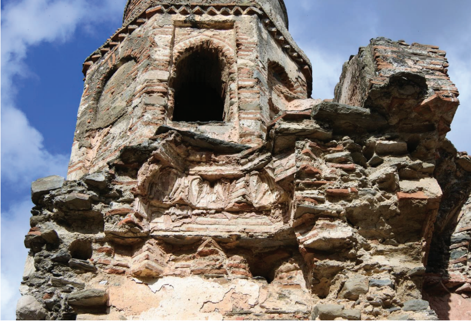
Fot. 12: Harimin batısındaki mekan içinde yer alan minare ve mekanın güney duvarı arasındaki alanın örtüsüne ait izler.
