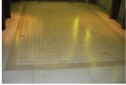
Fot. 29: Tonozlu mekanlarda zemin.
