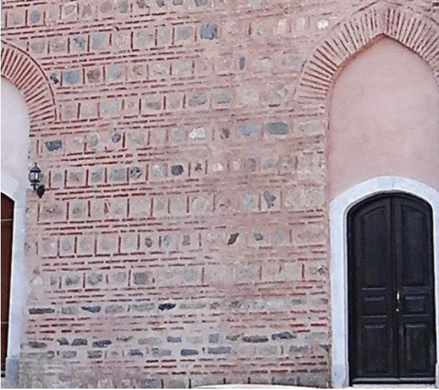
Fotoğraf 1: Bursa Muradiye Camii duvar örgüsünde kasetleme tekniği. (Fot. M. Kutlu)
