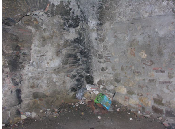
Fot. 18: 4 numaralı mekanın kuzey duvarındaki pencere ve doğu duvarı üzerindeki dolgu.
