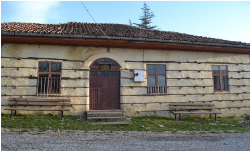
Foto. 3. Günümüzde Faal Olmayan, Yöreyle Özgü Mimari İle Yapılmış Okul Binasından Görünüm. Okul Binasının da Geleneksel Halk Mimarisini Yansıtmaları Oldukça İlgi Çekici Bir Özelliktir (22.03.2016, Belenalan Mahallesi- Akseki).
