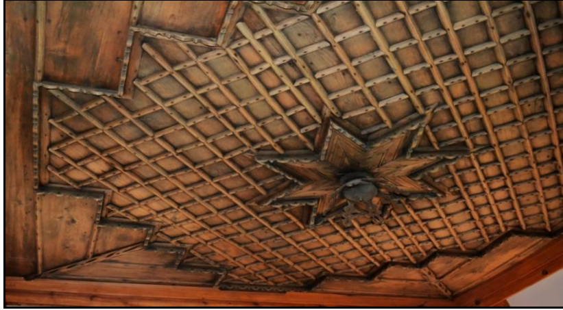
Foto. 2. İç Mekanda Tavan Süslemesi Örneği (21.10.2015, Cevizli Mahallesi-Akseki).
