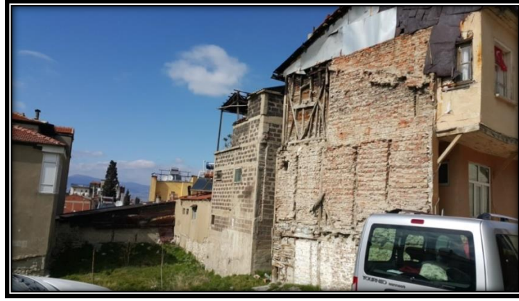
Şekil 10. Burdur Kentsel Sit Alanı ve Yakın Çevresinde Yığma Yapım Tekniği İle Yapılmış Yapı Örneği
