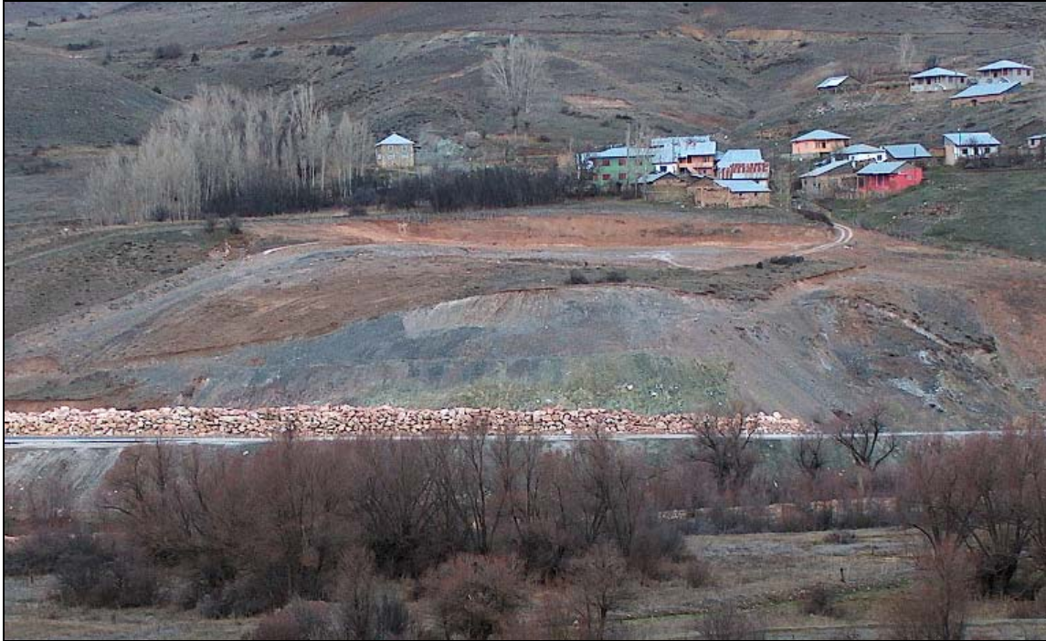
Şekil 3. Heyelandan sonra yapılan iyileştirme çalışmaları. Figure 3. Mitigation activities carried out after the landslide.
