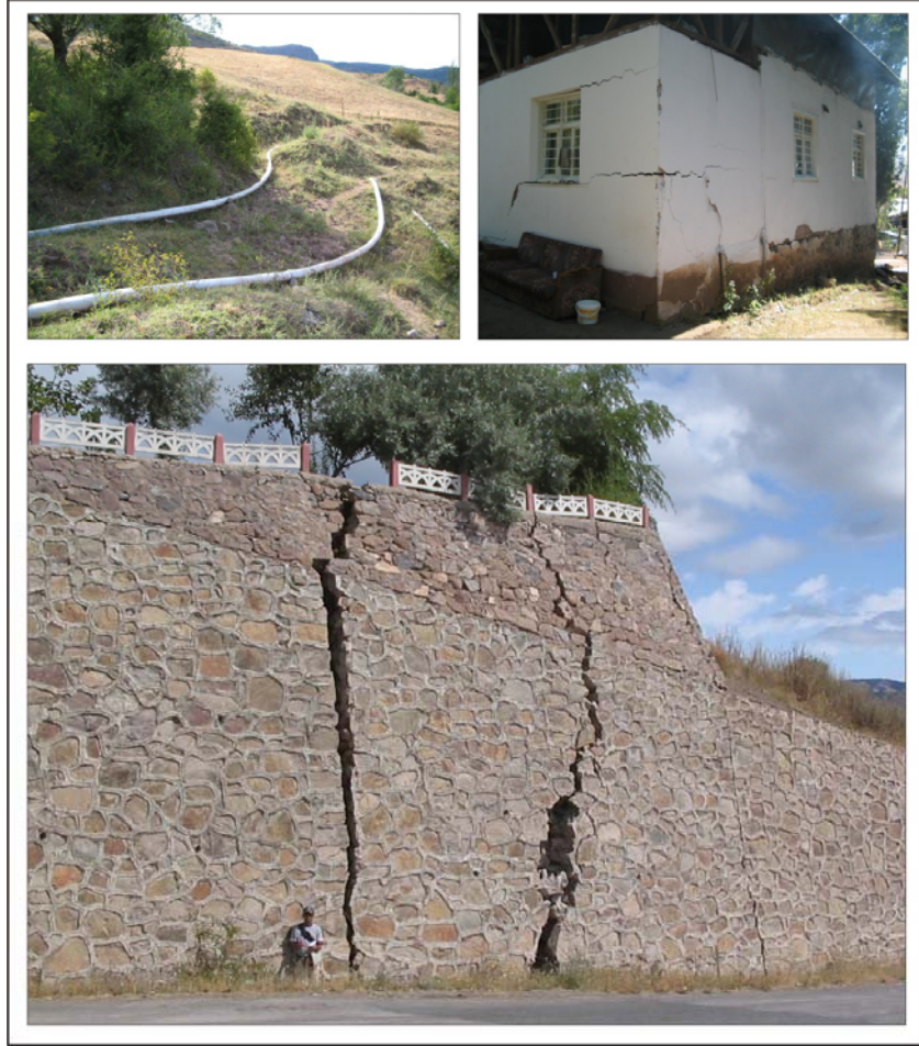
Şekil 2. Çalışma alanında kütle hareketlerinden etkilenen yapılar. Figure 2. Structure affected from mass movement in study area.
