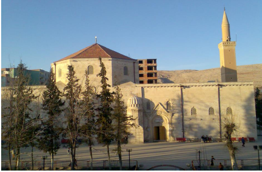
Resim 6- Güney cepheden mihrap önü kubbesinin görünümü
