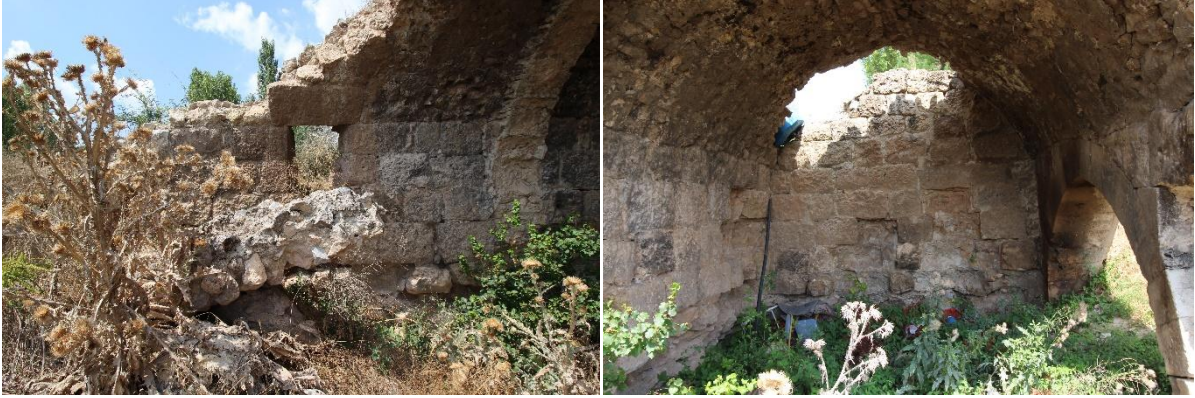
Çiftlik Hanı batı sahnin pencere ve tonoz örtü, malzeme-teknik
