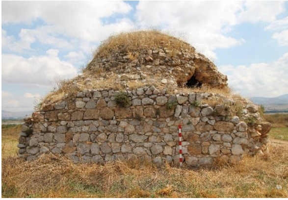
Fotoğraf 5 Batı cephe
