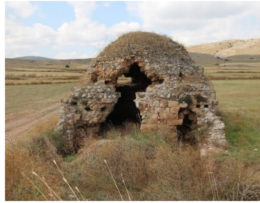
Fotoğraf 6 Doğu-Giriş Cephesi
