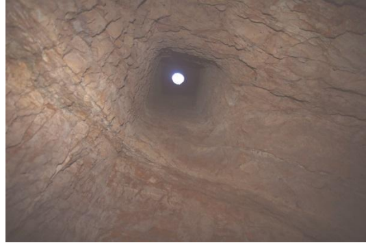
Fotoğraf – 8 (Havalandırma noktası)
