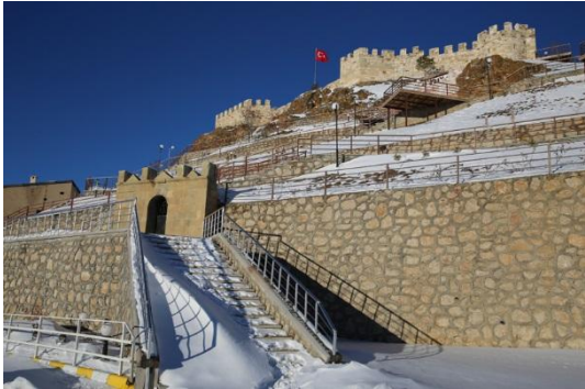
Fotoğraf – 11 (Aydın-tepe Kalesi'nin altında konumlanan yeraltı şehri çıkış kapısı) 6
