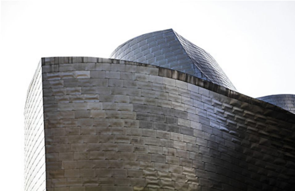
Resim: 3 Titanyum Cephe Kaplaması. (Fotoğraf: Mehmet Can Sarı, 2013).
