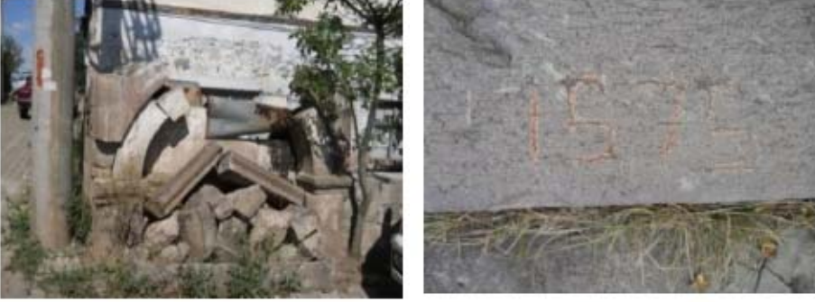
Resim 26: : Şebinkarahisar içerisinde bulunan bir çeşme ve eski yapı unsurları. Merkez Kilisesi'ne yakın bir alanda bulunan yazılı ve tarihli taş bloklardan biri.
