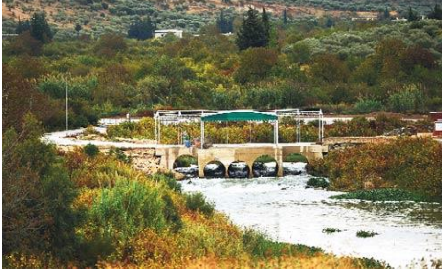
Foto 3. 2012 yılında temeli atılan fakat yapımı henüz tamamlanamayan Dostluk Barajı (Kaynak: www.milliyet.com.tr)
