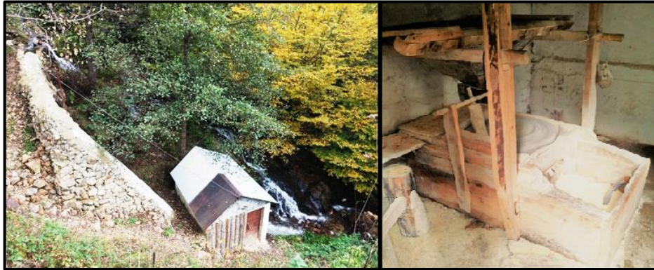
Foto 2: Su gücüyle çalışan bir değirmenin dışarıdan ve içeriden görüntüsü (Balıkcak/Bayıncı Köyü).
