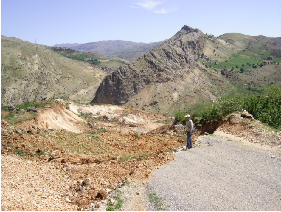
Foto 4. 30 Ocak 2010 tarihinde gerçekleşen heyelanda, Tepecik ve çevresindeki yerleşmeleri Adıyaman'a bağlayan yol tahrip olmuştur.
