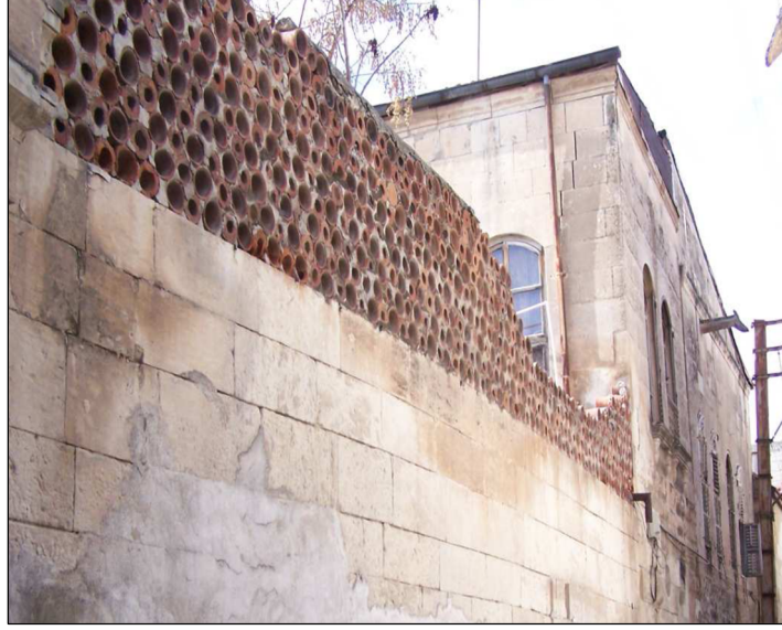
Foto 2. Belli Yükseltiden Sonra Sokak Duvarlarının Delikli Yapılışı (Bebah): Kilis geleneksel evlerinde avlu sokaktan yüksek bir duvarla ayrılmıştır. Belli yükseltiden sonra bu duvarlarda delikli olarak yapılarak havanın içeri alınması sağlanmıştır. Hatta bu delikli yapıların dışarı bakan tarafı geniş içe bakan tarafı dar yapılarak havanın vakumlanması (emilmesi) sağlanırdı. Yerel dilde bu yapıya "Bebah" adı verilmektedir.
