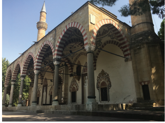
Fot. 1: Sultan Camii ön cephesi, son cemaat yeri. Güney batıdan görünüm.
