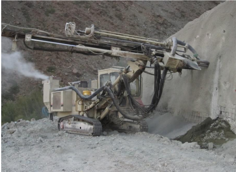
Şekil 7. Tünel Portal Bulon Deliklerinin Açılması
