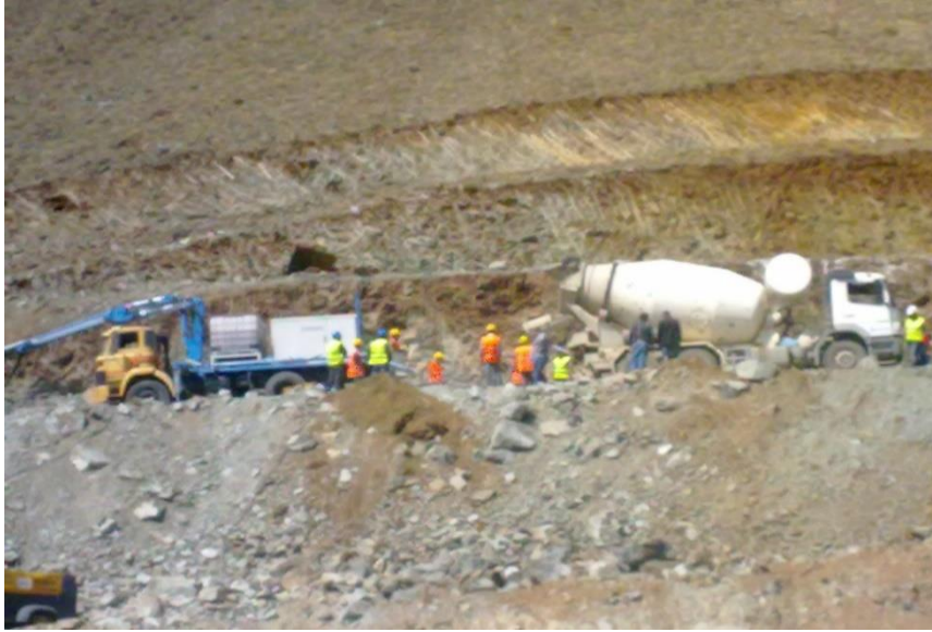
Şekil 5. Kop Dağı Tüneli Giriş Portalı Kazısı
