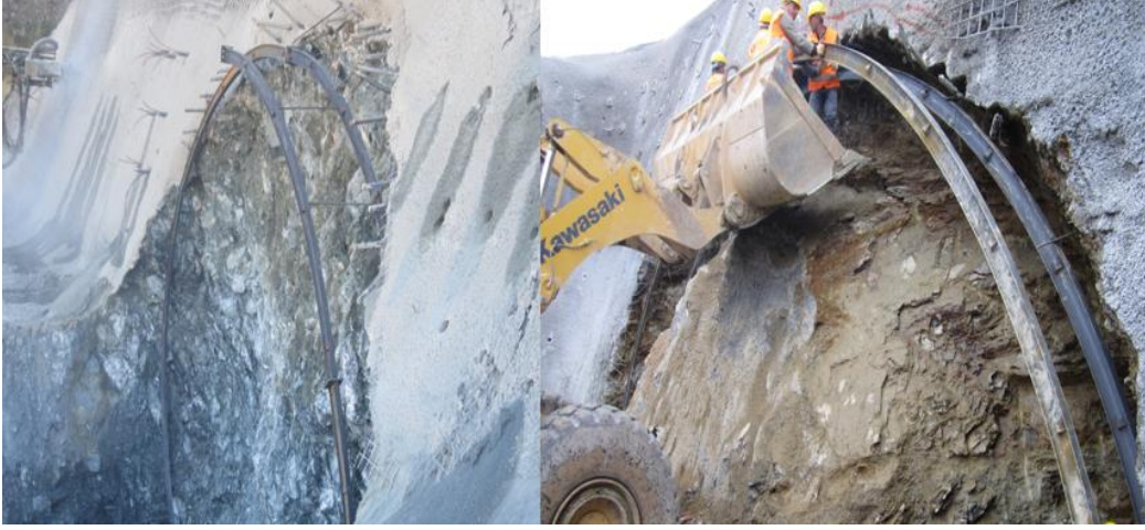
Şekil 8. Kop Tüneli Çelik İksa Çalışmaları.
